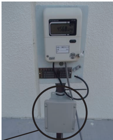
水道スマートメータの設置イメージ (既設水道メータ表示器の下部)
