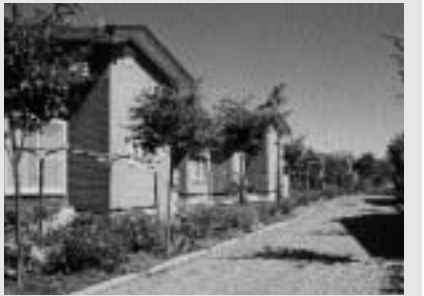
194戸の町営住宅に火災報知器が設置
