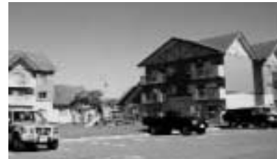
外壁改修を行うシャーレーイストタウン
