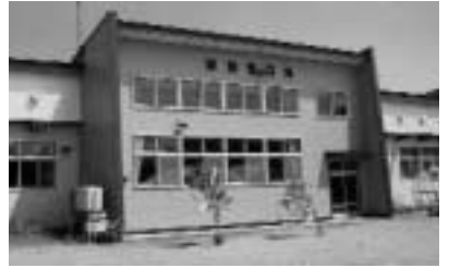
屋根防水補修工事が行われる各保育所
