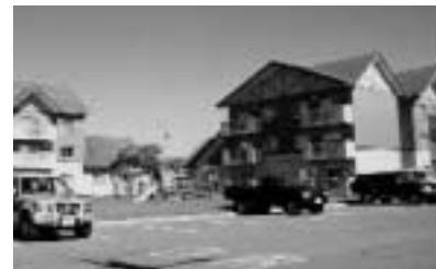
外壁改修を行うシャーレーイーストタウン
