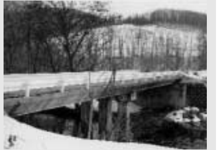
橋の耐震化・長寿命化の点検を実施
