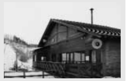
外壁の塗装を行うスキー場ロッジ
