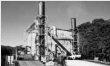
焼却炉の改修と耐火物補修を行います
