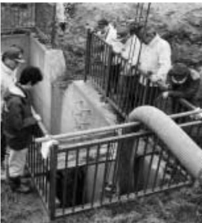
岩富地区の樋門
