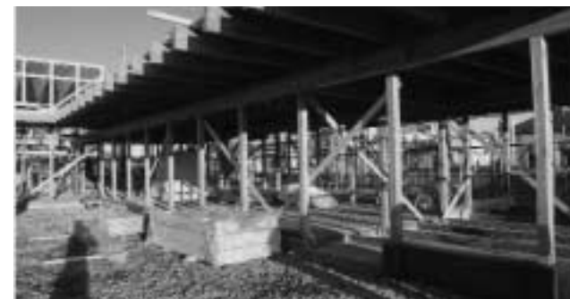
【建設途中の多目的活動センター】
