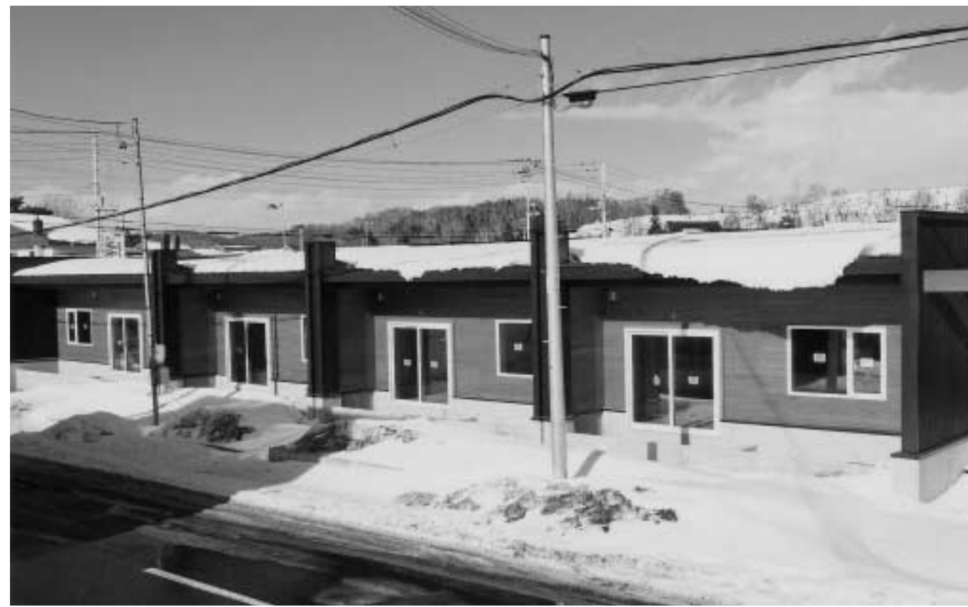
旧営林署に現在建設中のまちなか団地
