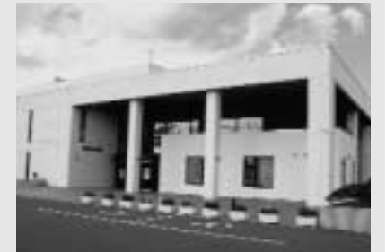
社会教育施設の屋上を改修します
