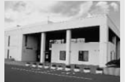
社会教育施設の屋上を改修します
