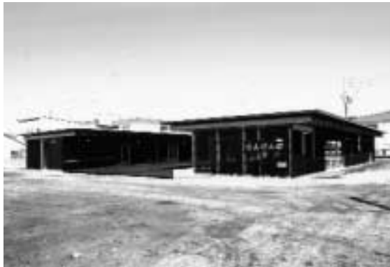
4月1日にオープンした『津別町多目的活動センター』
