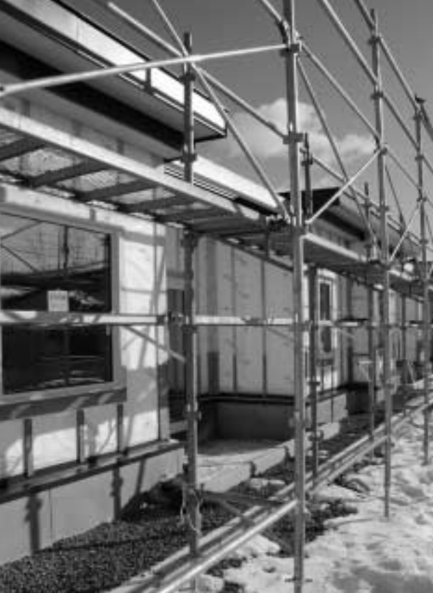
3月完成を目指し建設中のまちなか団地
