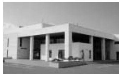
改修工事が行われる中央公民館
