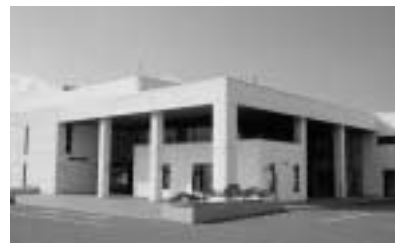
改修工事が行われる中央公民館
