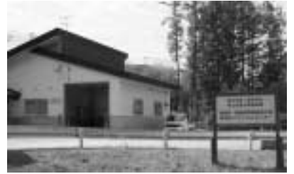
一般廃棄物最終処分場
