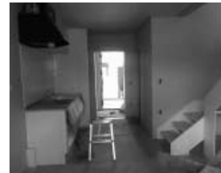
工事中の室内（居間から玄関を見る）
