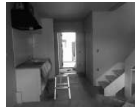
工事中の室内（居間から玄関を見る）
