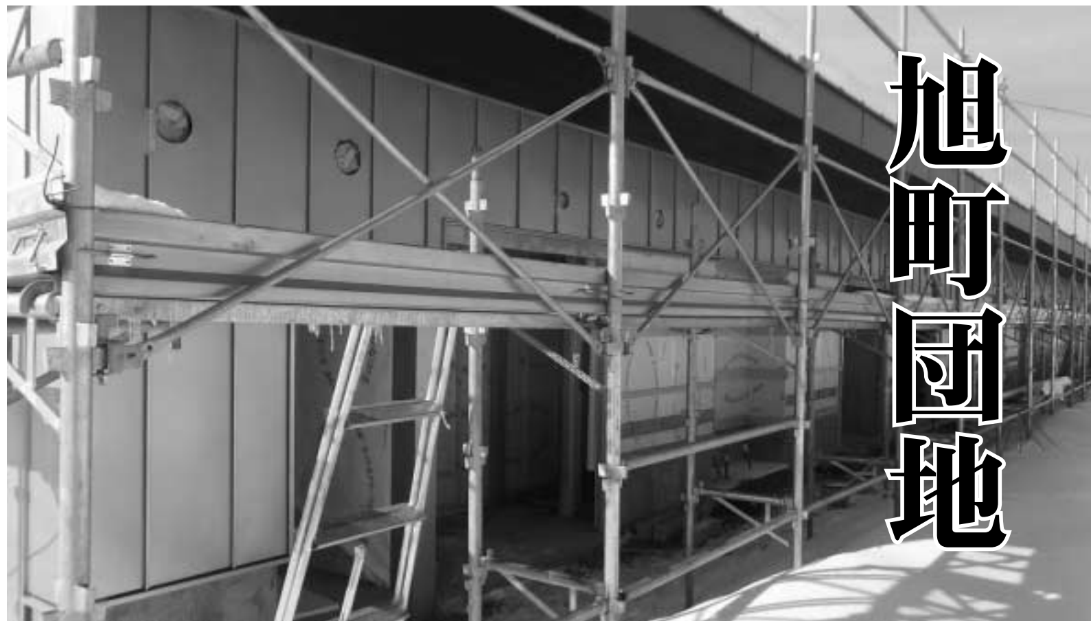
建設中の旭町団地・町営住宅
