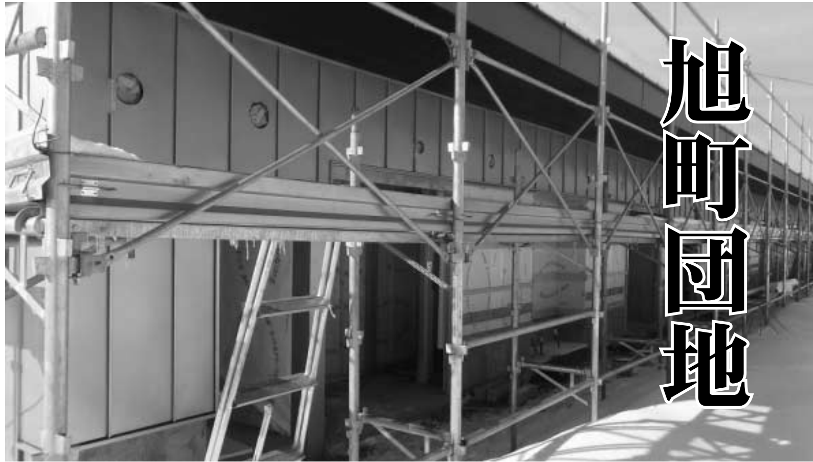
建設中の旭町団地・町営住宅
