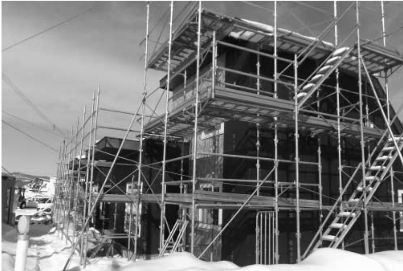
建設中の旭町団地・特定公共賃貸住宅
