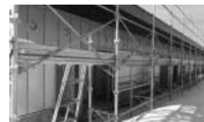
町営旭町団地
