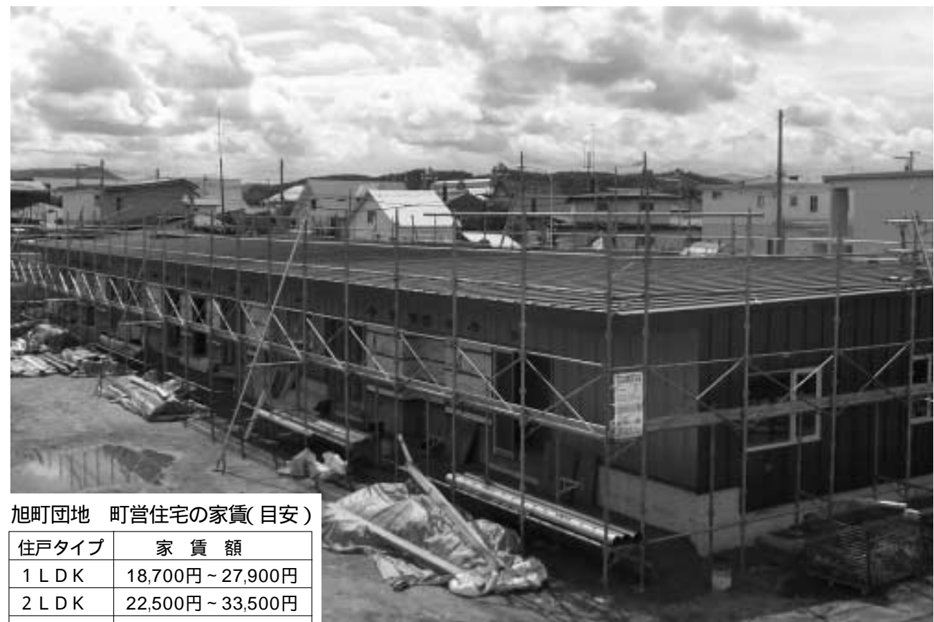
建設中の旭町団地・町営住宅
