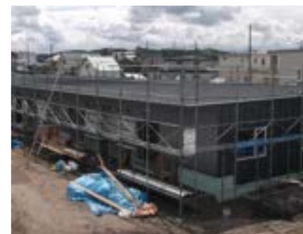
まちなか団地 (写真は旭町団地建設時の様子)
