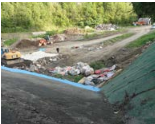
▲既存の最終処分場の状況
