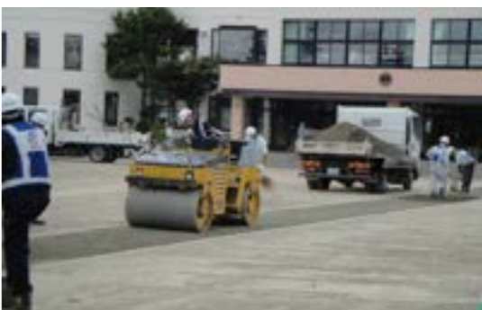
▲小グラウンド舗装整備工事の様子
