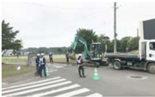
▶津別小学校裏口舗装整備工事の様子
