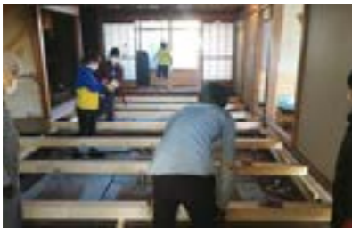
▲一般参加型の空き家改修ワークショップの様子
