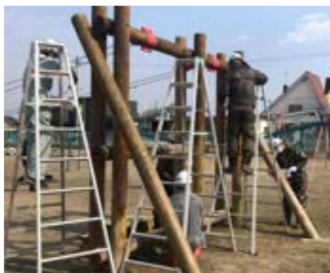
▶塗装修繕の様子
