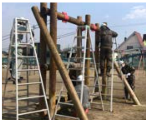
▶塗装修繕の様子
