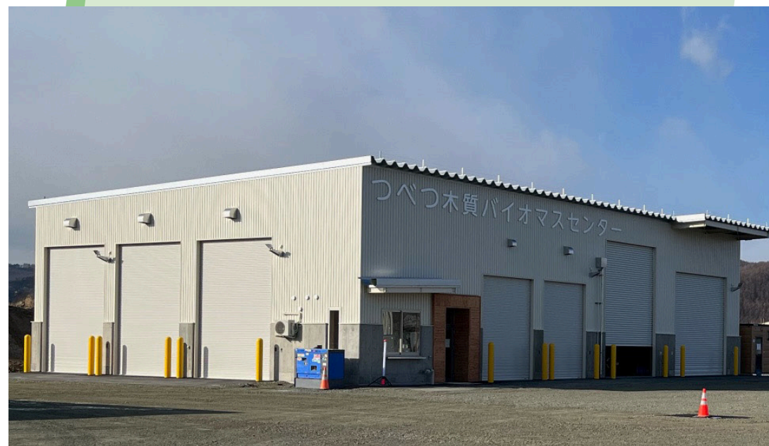
建設中のつべつ木質バイオマスセンター
