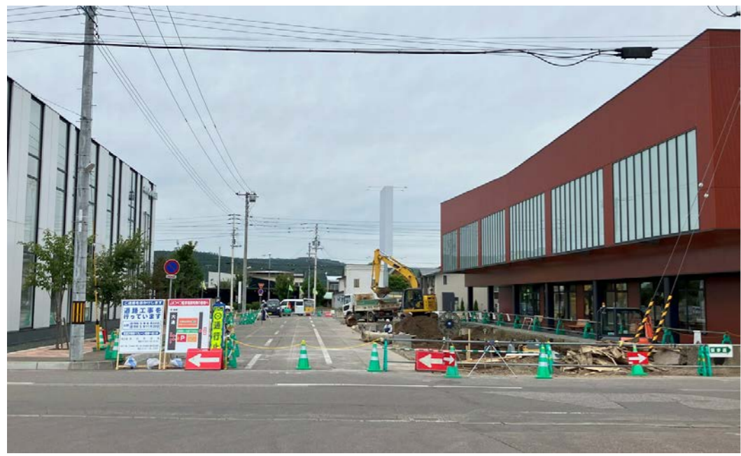
▲ 終日通行止めとなっている町道31号線改修とバスレーン工事の様子
