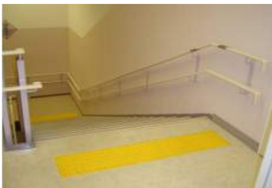
二段手すりを採用した階段
