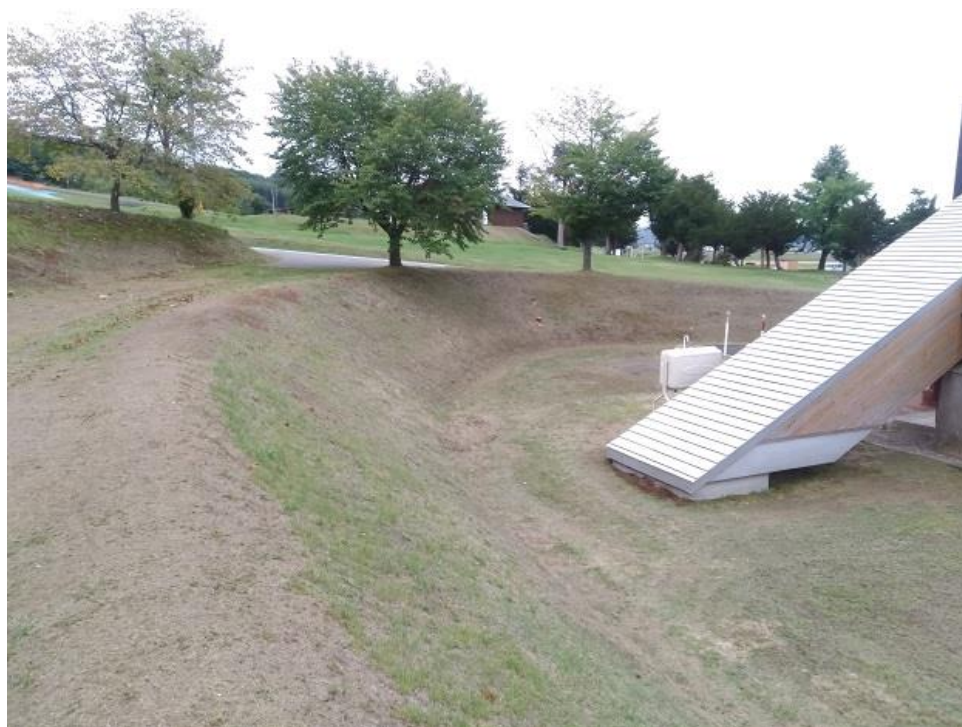
図 3-22 つべつ木材工芸館「キノス」の搬入ルート：搬入ルート案の未舗装路
