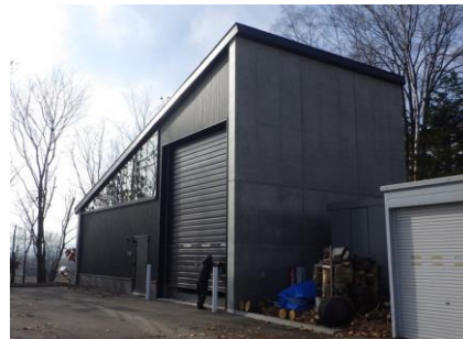
大樹町：木質バイオマスエネルギー棟
