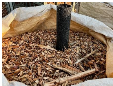
フレコン後列 b に暗渠排水管を組み込む
