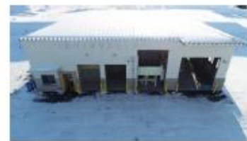
つべつ木質バイオマスセンター②
