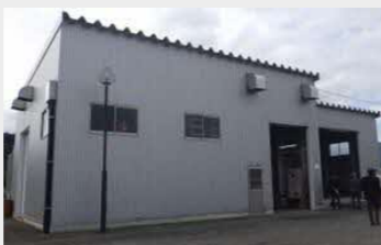
木質バイオマスボイラー棟
