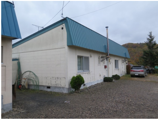
公営住宅：西町第2
