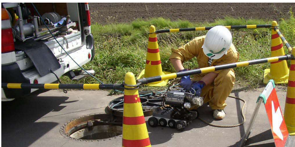
図 6-3 公共下水道管渠テレビカメラ調査（津別町内）
