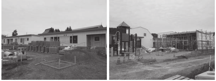
建設が進む西町団地
