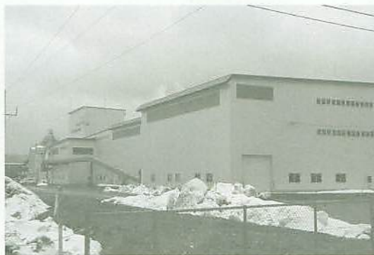
今年3月に操業開始になった針葉樹合板工場
