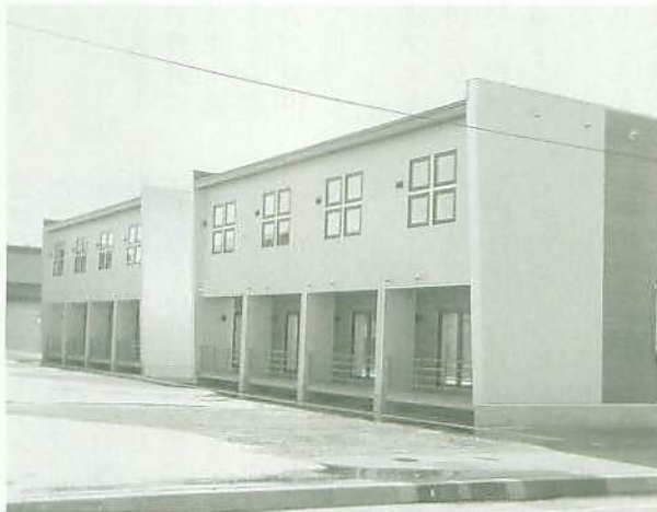
平成14年度に建設された「たつみ第3回地」
