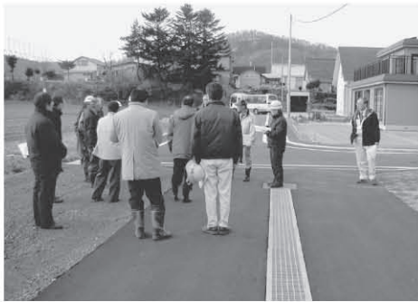
改良舗装工事の完成した共和の町道186号線
