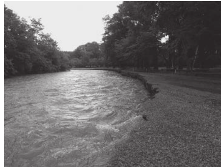
増水で川岸が削られた河岸公園
