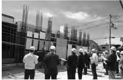
役場新庁舎建設現場の現地視察 (6/3)
