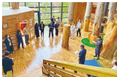
木材工芸館キノス天井改修工事 完成箇所の現地視察（6/5）
