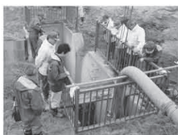
岩富地区の樋門
