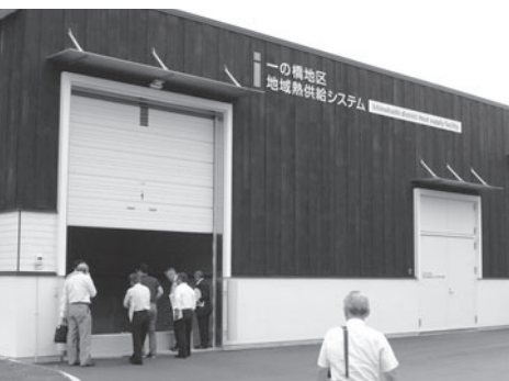
地域熱供給システム施設（下川町）
