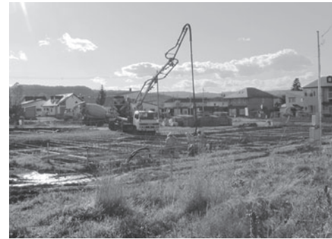
建設の始まった旭町団地
