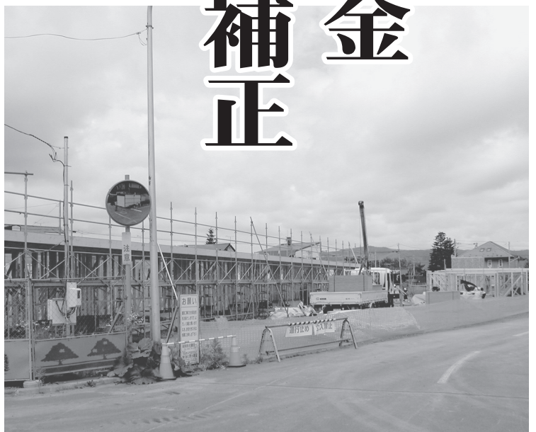
建設が進む旭町団地
