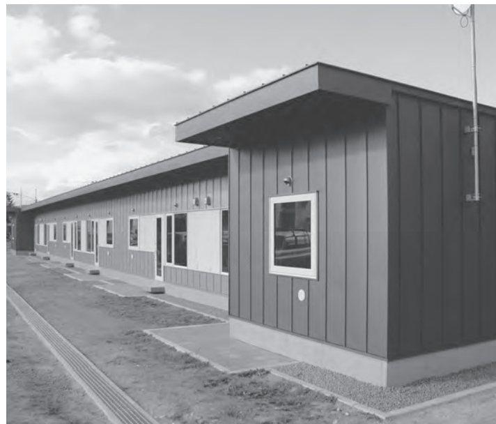
全住宅が完成した旭町団地
