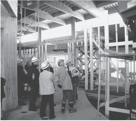
こども園建設現場の視察
